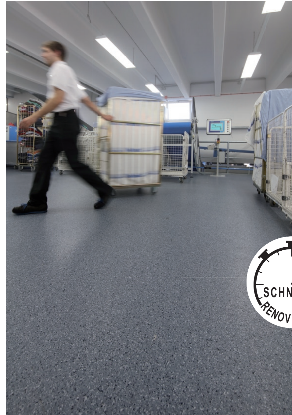
Lose verlegbare und selbstliegende Fliesen in der Wäscherei Bohnet in Ulm
